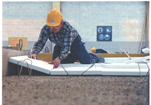
Abb. 8 Einlegen der Wärmedämmung
