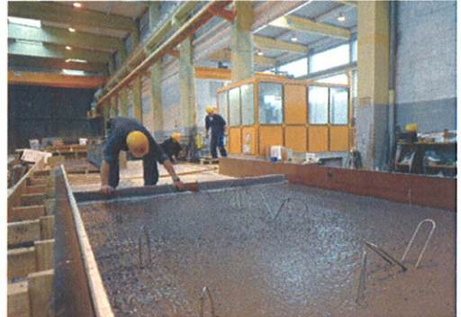
Abb. 7 Fertigstellung der Vorsatzschale
