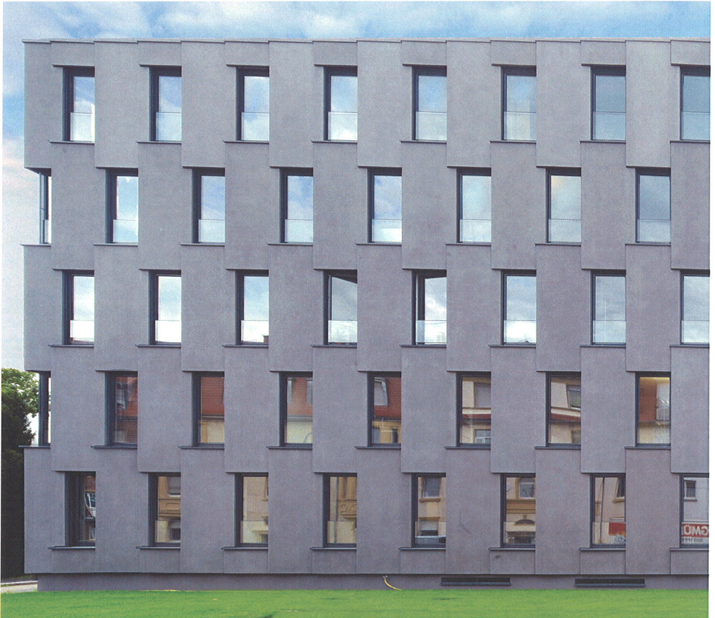
Abb. 4 Das Scheibenraster unterstreicht den Solitärcharakter des Bürogebäudes
